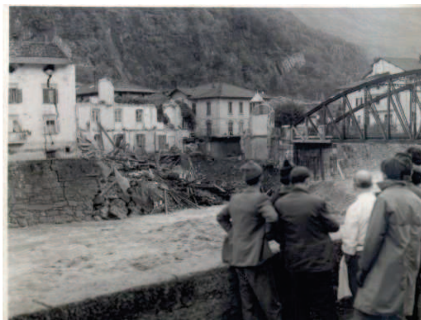
Figura 4: 1966, case crollate in seguito all'ondata di piena del torrente Avisio
