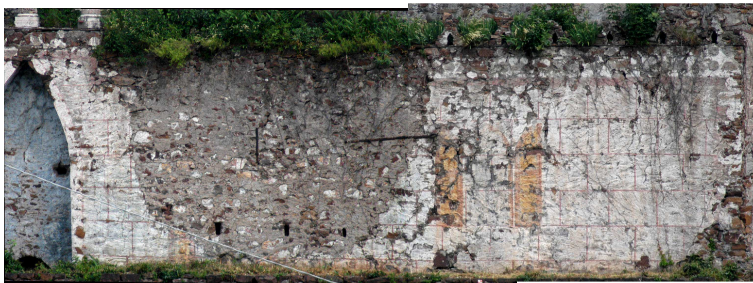
7.-8. Particolari del muro del “palazzo” denominato D4 con le parti decorate che saranno oggetto dei lavori di restauro pittorico.
