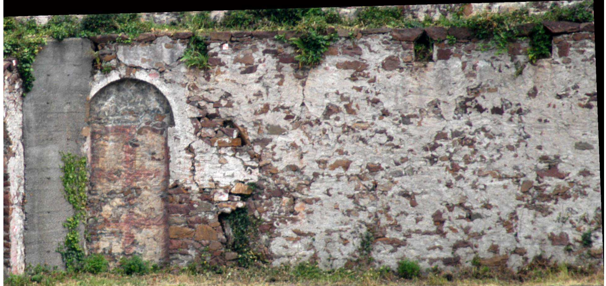
5.-6. Particolari dei muri denominati C3 e C4 con le parti decorate che saranno oggetto dei lavori di restauro pittorico.
