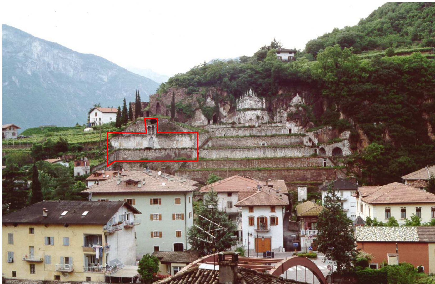
1. Il complesso monumentale del Giardino Bortolotti detto dei “ciucioi” nel 2002 prima dei lavori di restauro. (in rosso l'area da restaurare oggetto della richiesta di finanziamento).
