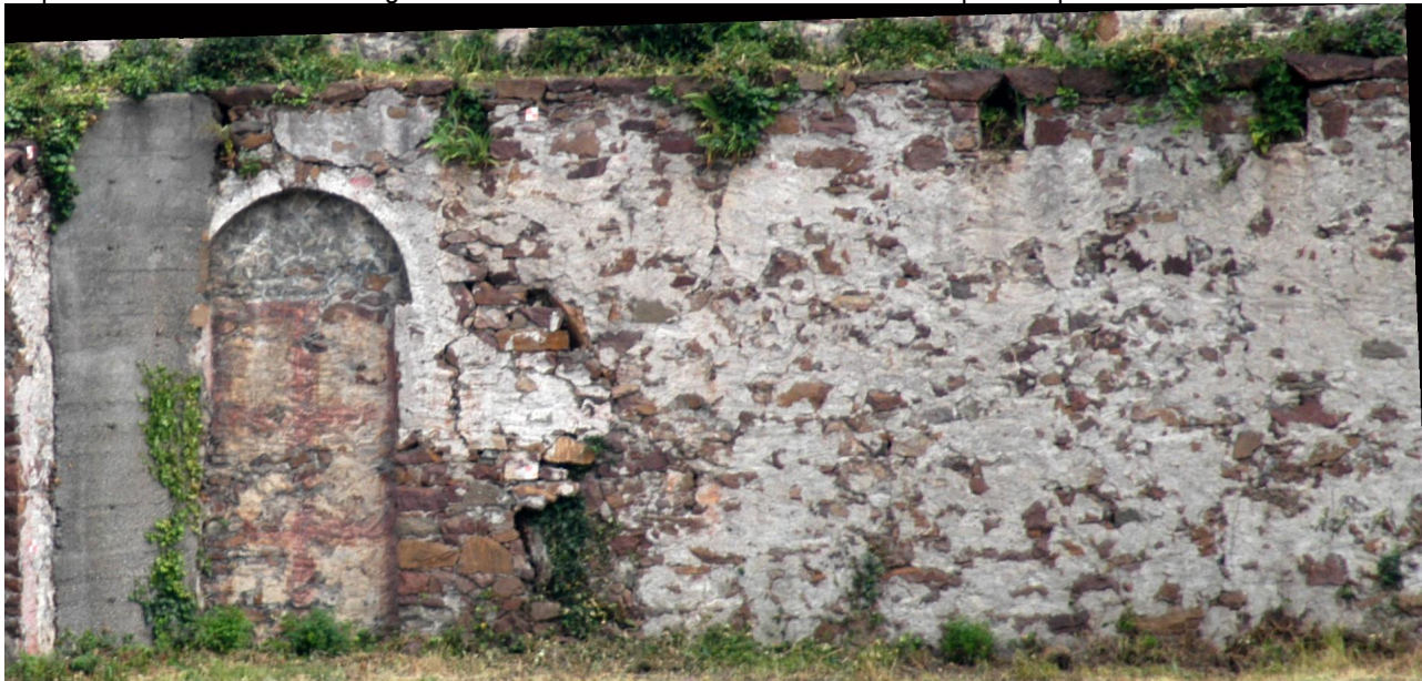
Fig. 10 : Lavis (TN) Giardino Bortolotti detto dei "Ciucioi" muro C4 dettaglio dell'arco cieco.
