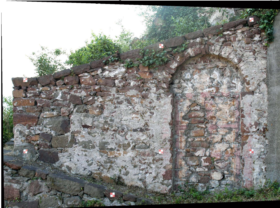
Fig. 11 : Lavis (TN) Giardino Bortolotti detto dei "Ciucioi" muro C3 dettaglio dell'arco cieco.
