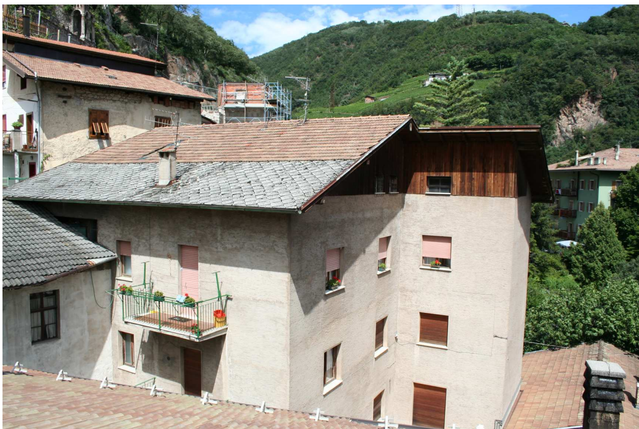
Va evitato l'uso di intonaci con lavorazioni superficiali non caratteristiche dell'organismo
