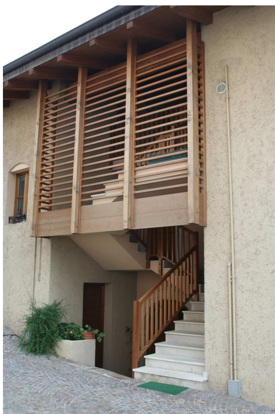
Scala in cls con mascheramento ligneo
