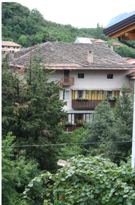
Copertura in lastre di porfido
