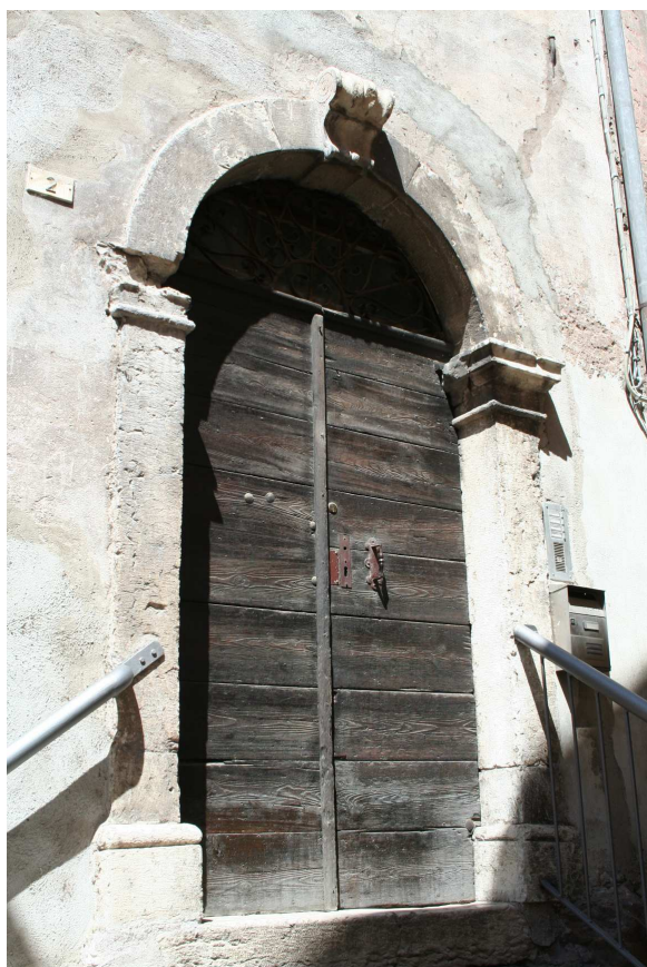
Portale con apertura sotto la chiave di volta per areazione e ante in legno
