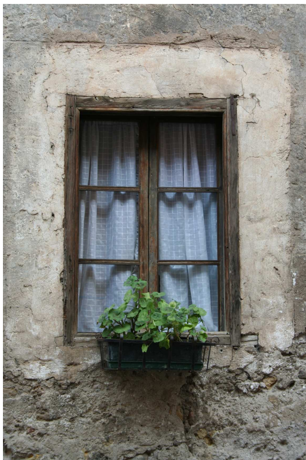
Vecchia finestra lignea con specchiature
