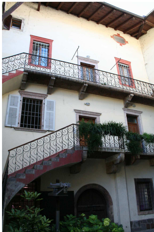
Scala in muratura con ringhiera in ferro
