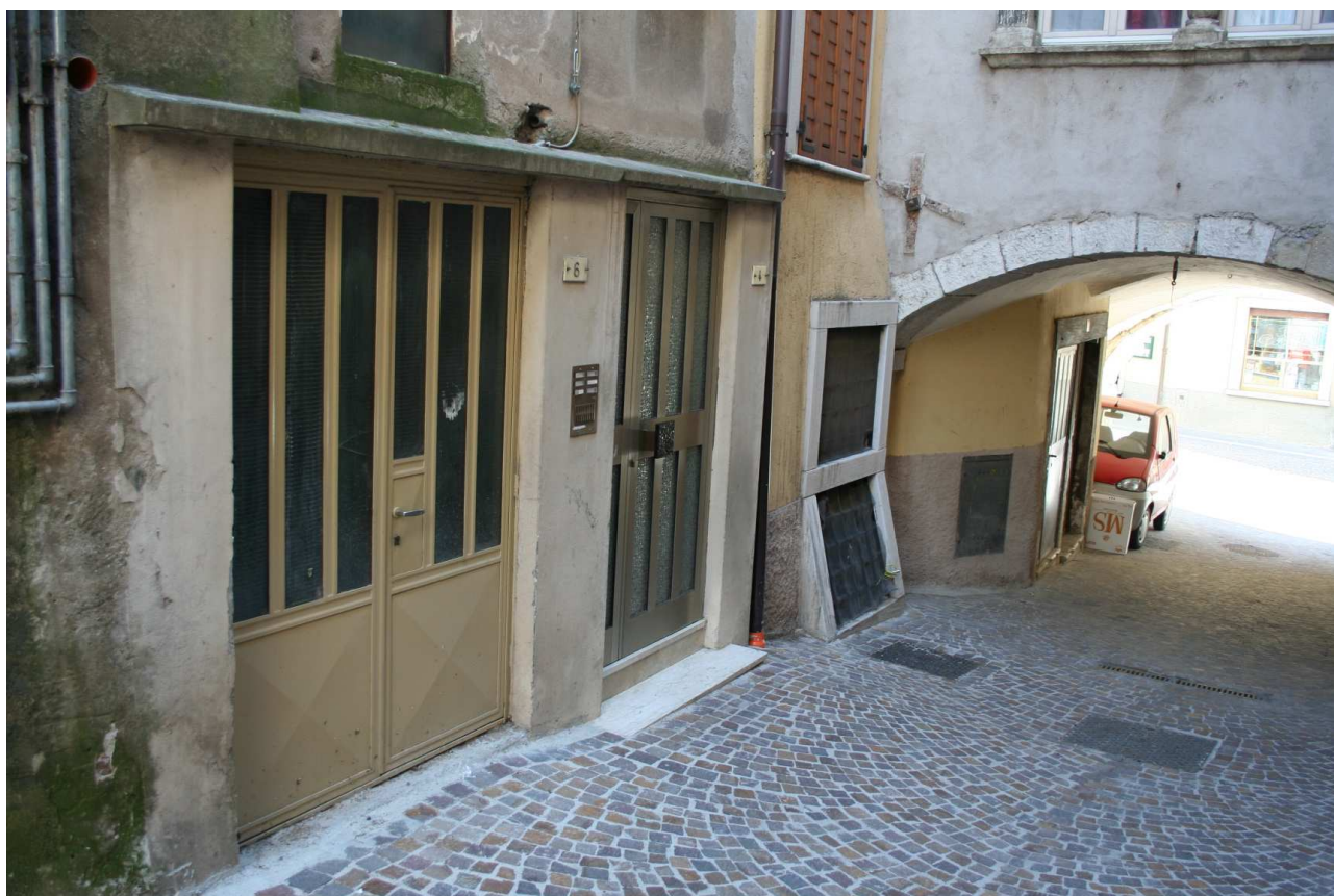
Vanno evitati i serramenti in alluminio anodizzato
