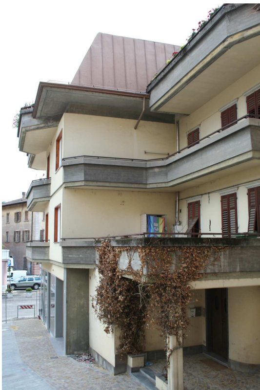
Va evitato l'uso del calcestruzzo lasciato a vista
