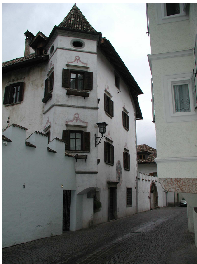
Copertura a cuspide a piramide di un erker
