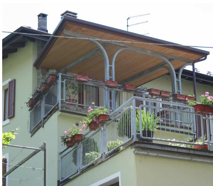
Uso di materiali non tradizionali con ringhiere non facenti parte dei sistemi costruttivi tradizionali
