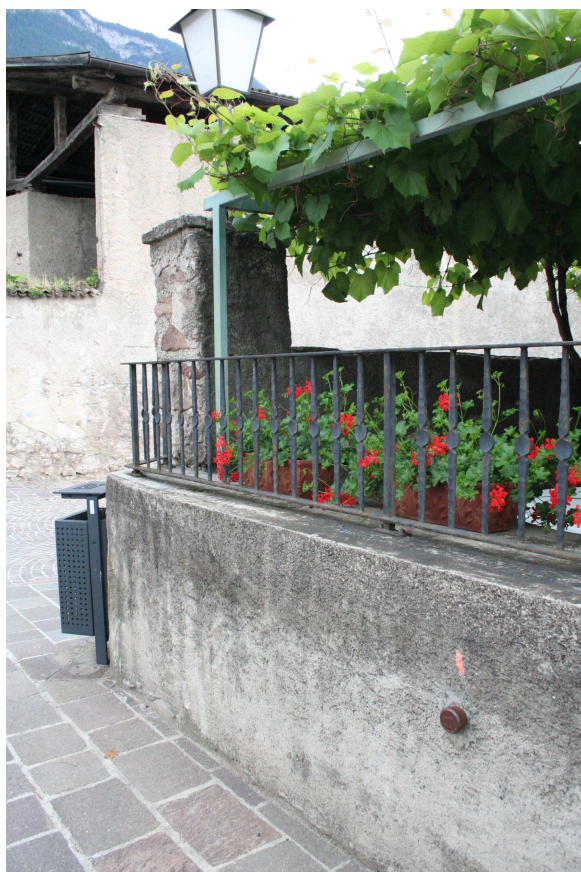
Muratura con parapetto in ferro
