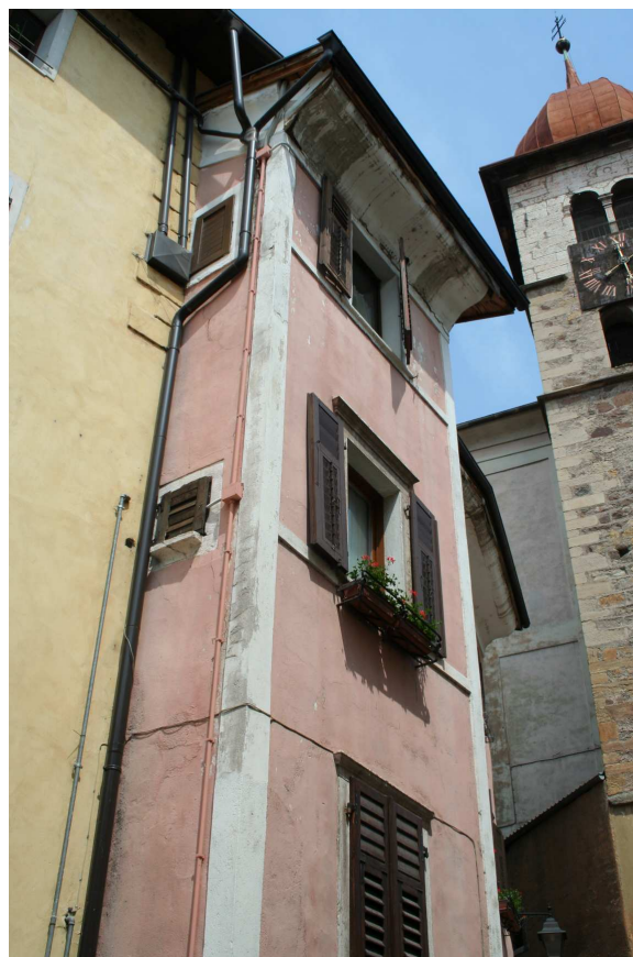
Fasce d'angolo e marcapiano
