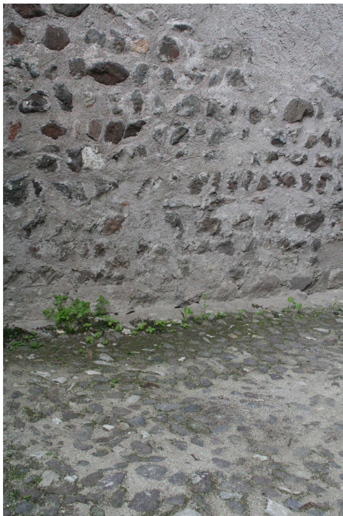
Pavimentazione in selciato
