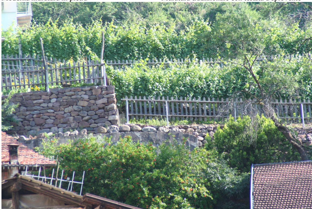
Corrette staccionate lignee posizionate sopra i muri di terrazzamento in pietra a vista sul Pristol
