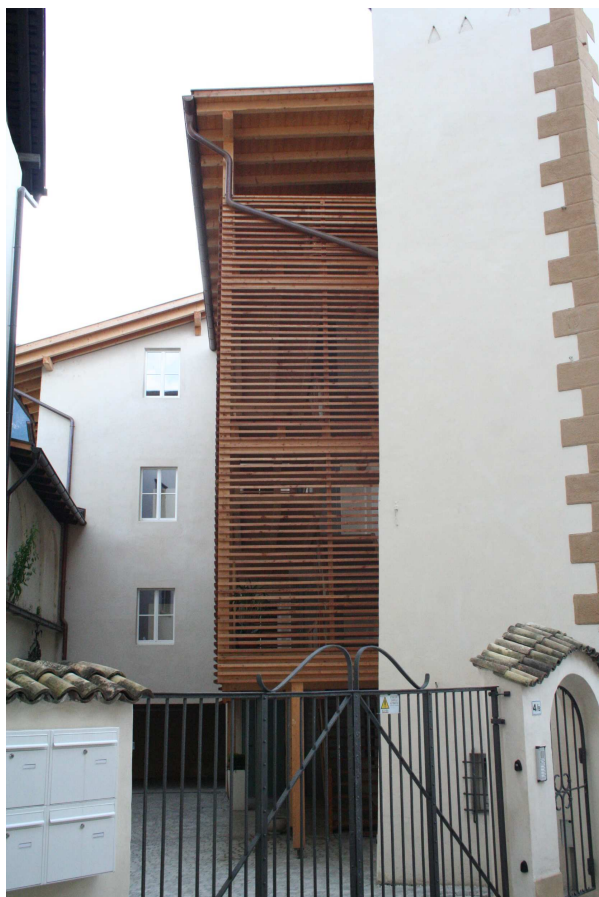
Corrette tamponature di scale con listelli in legno
