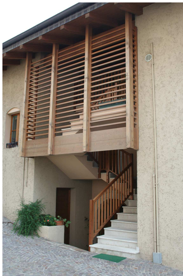
Corrette tamponature di scale con listelli in legno
