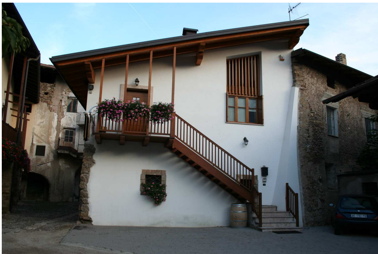
Scala esterna in legno
