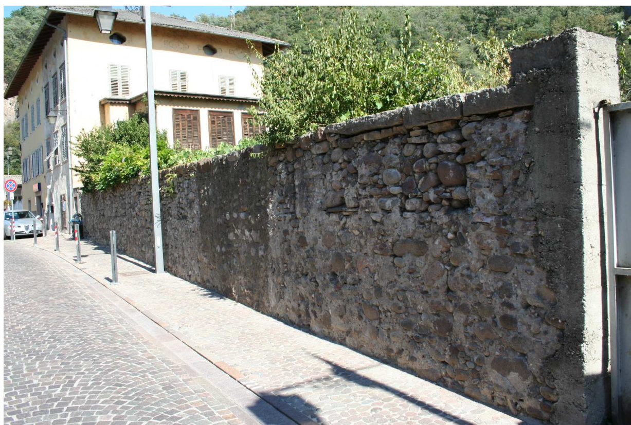
Muratura in pietra tradizionale
