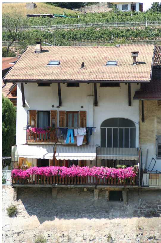
Copertura in tegole
