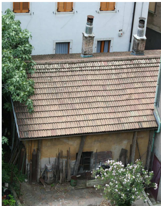
Copertura in tegole
