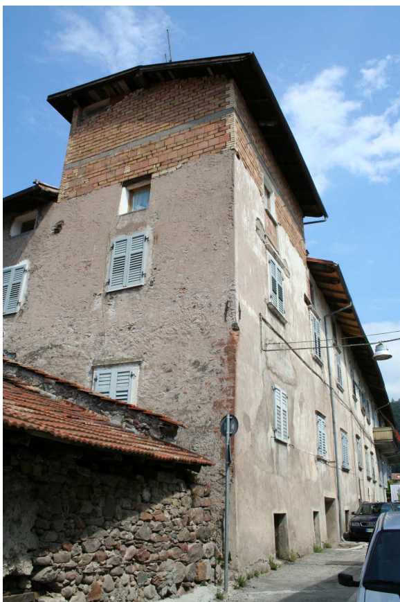
Va evitato il lasciare a vista mattoni in laterizio
