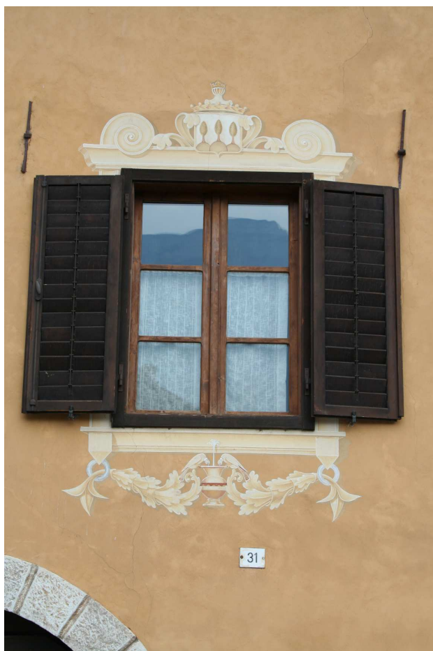
Finestra tradizionale a due ante con specchiatura
