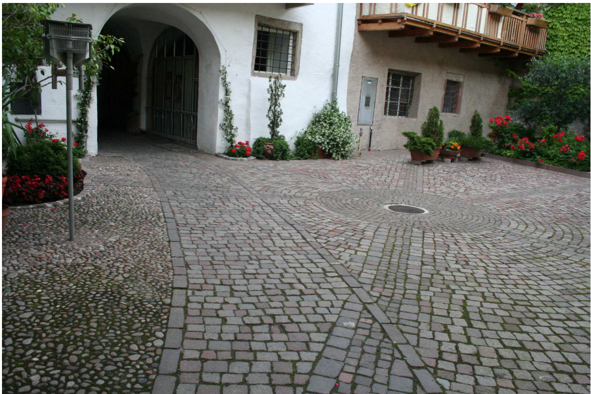
Diversi tipi di pavimentazione in porfido
