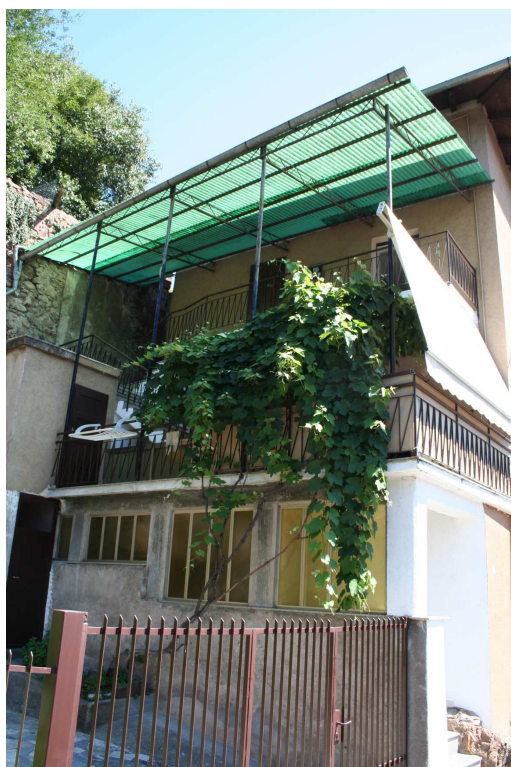
Uso di materiali non tradizionali con ringhiere non facenti parte dei sistemi costruttivi tradizionali
