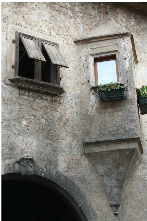
Antico intonaco a finto bugnato
