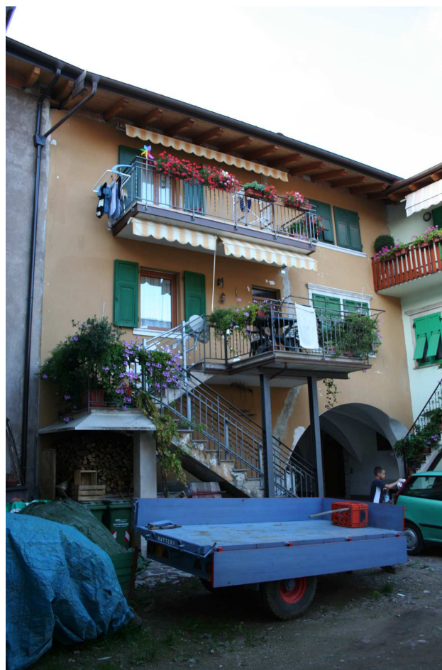
Vanno evitate le strutture in cemento armato a vista
