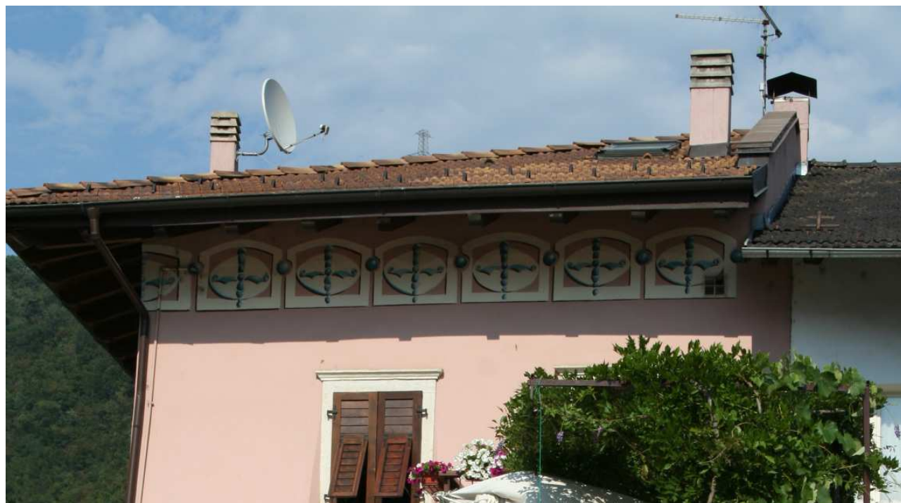
Le antenne paraboliche dovranno essere possibilmente centralizzate e montate sulla copertura
