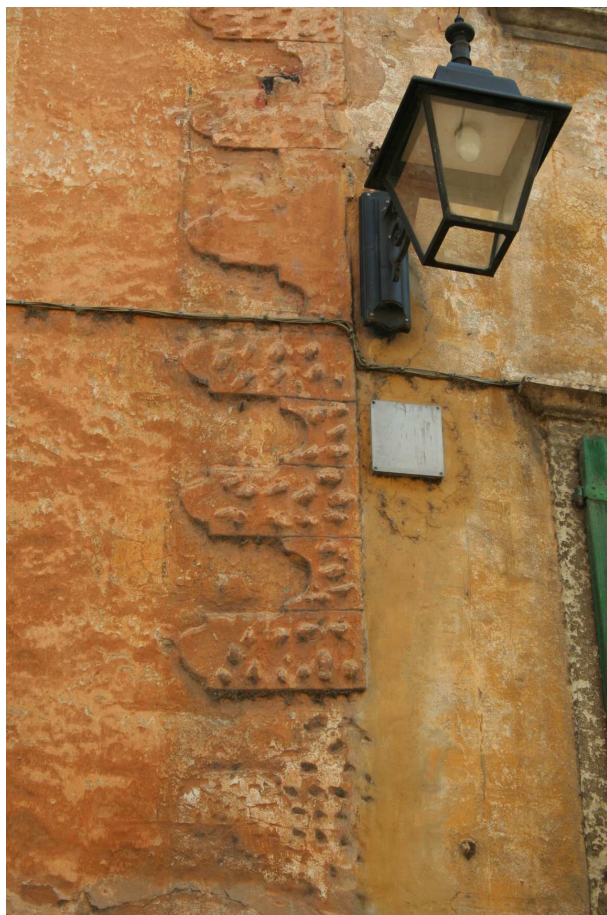
Conci d'angolo a rilievo con inserti di acciottolato Conci d'angolo a rilievo e finestre orbicolari
