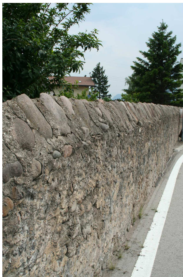
Muratura tradizionale con testata a spiovente
