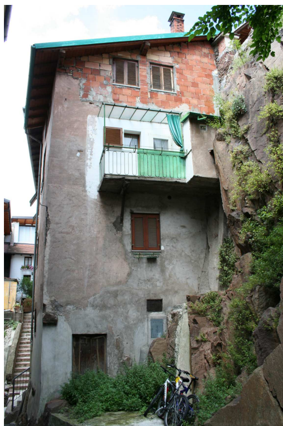
Va evitato il lasciare a vista mattoni in laterizio
