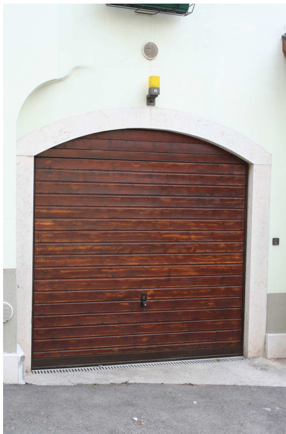
Portone di accesso a un garage
