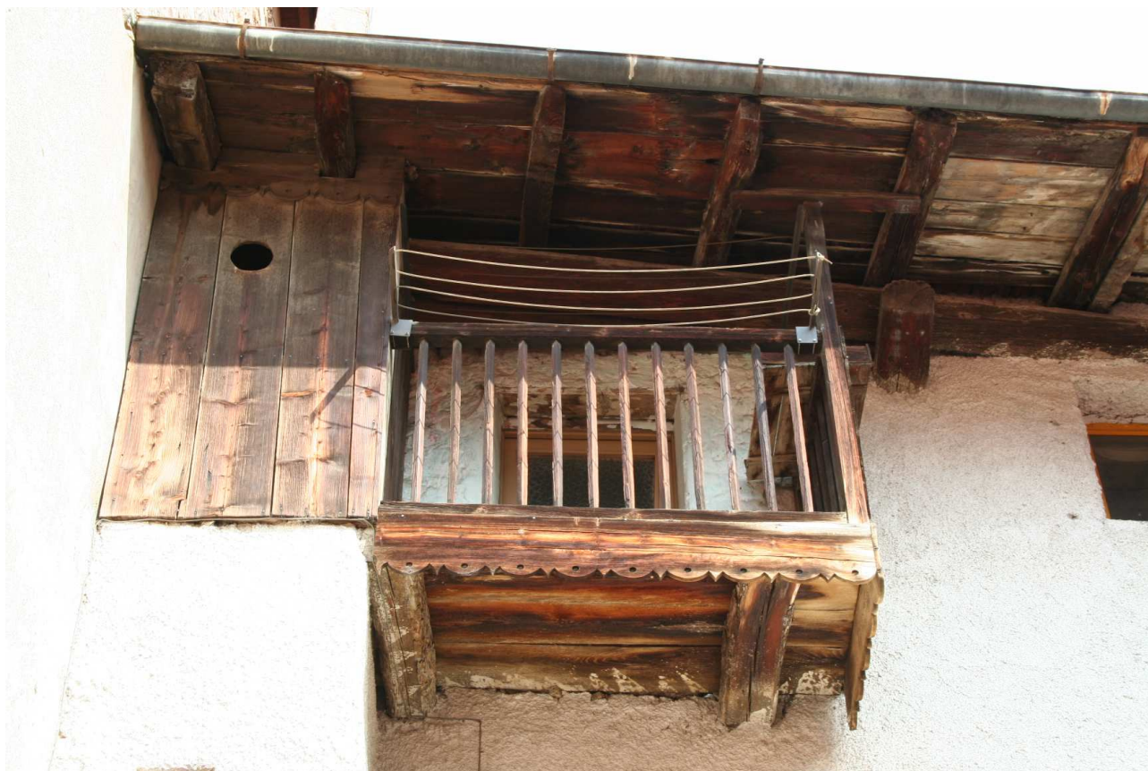
Corretto antico ballatoio in legno con finiture tradizionali
