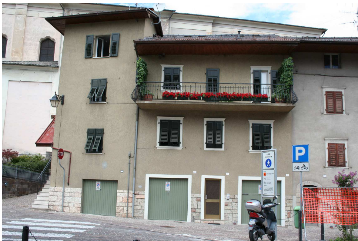
Va evitato l'uso di intonaci plastici
