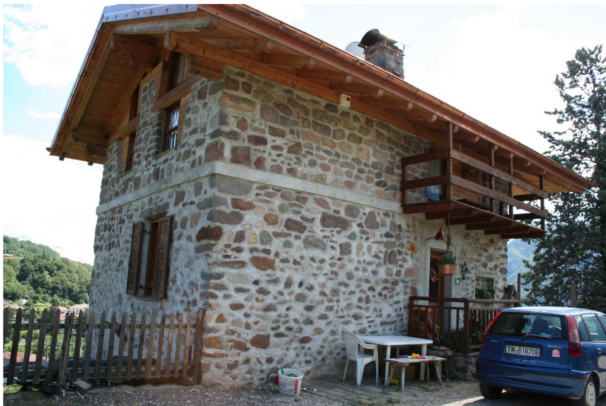
Corretto uso del materiale lapideo e di tamponamenti lignei
