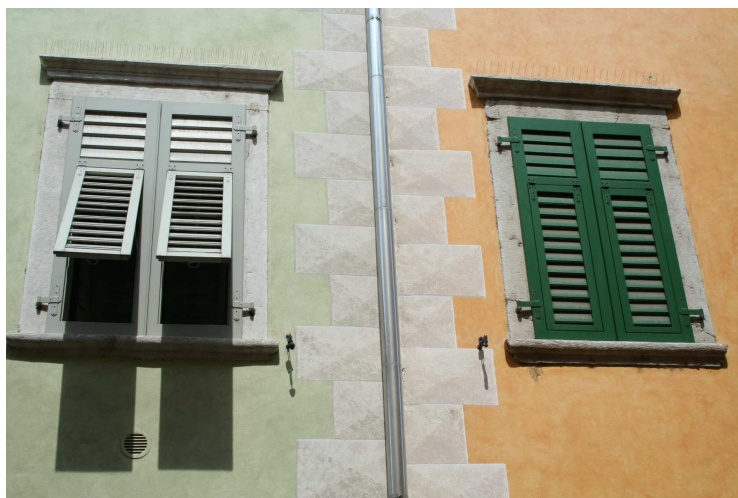
Pluviale in lamiera zincata
