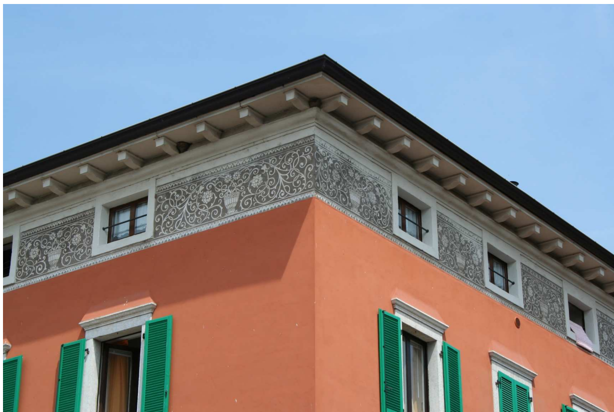
Decorì nella fascia sotto gronda
