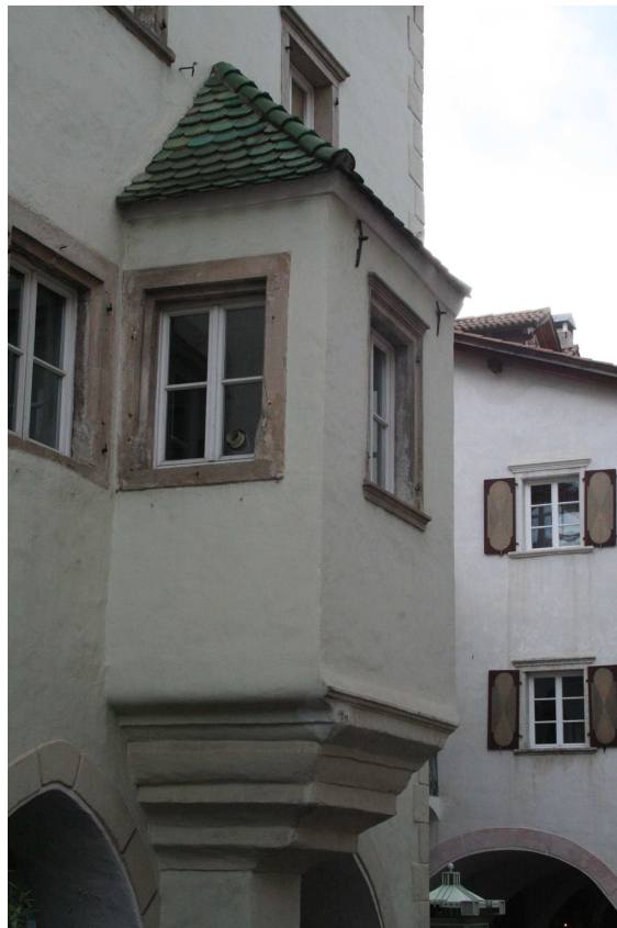
Corretta copertura di un erker
