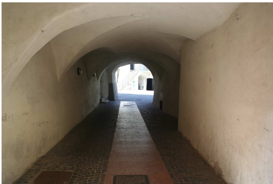
Corretta pavimentazione di un porticato nel centro storico di Lavis
