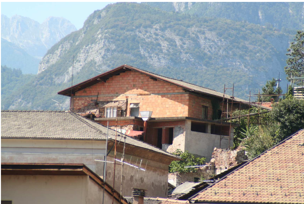
Va evitato il lasciare a vista mattoni in laterizio
