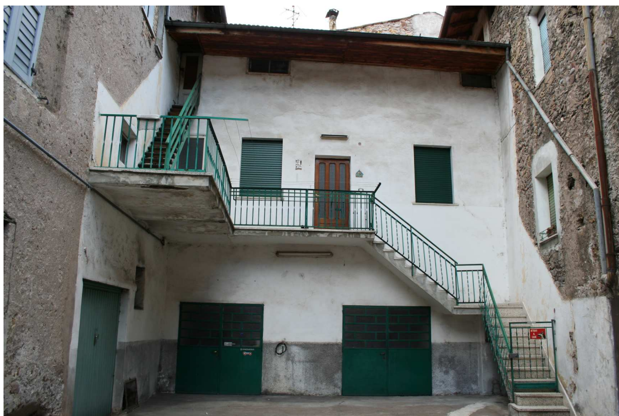
Vanno evitate le strutture in cemento armato a vista
